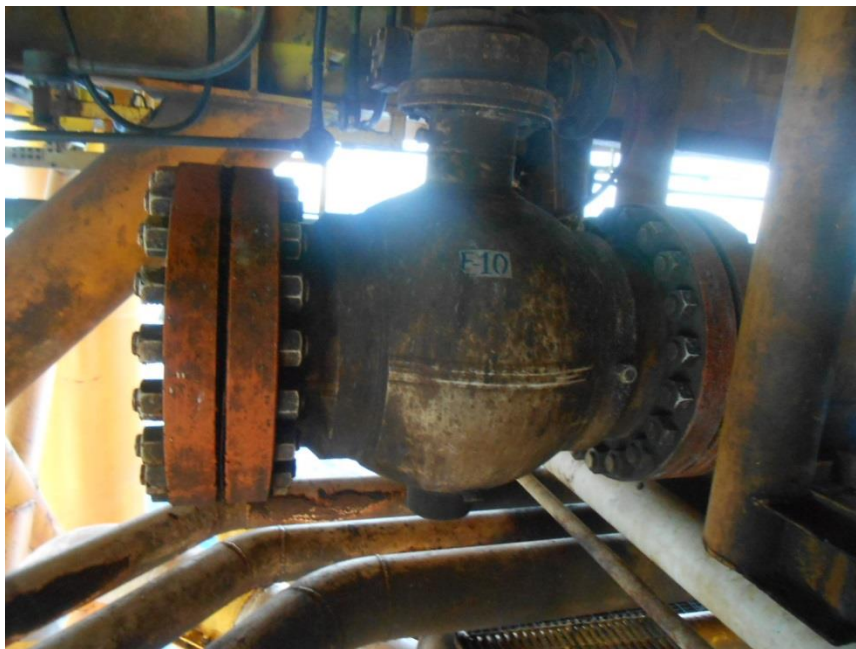
Fig. 2 Válvula disponible de 14" para interconexión del paquete de separación de sólidos.
